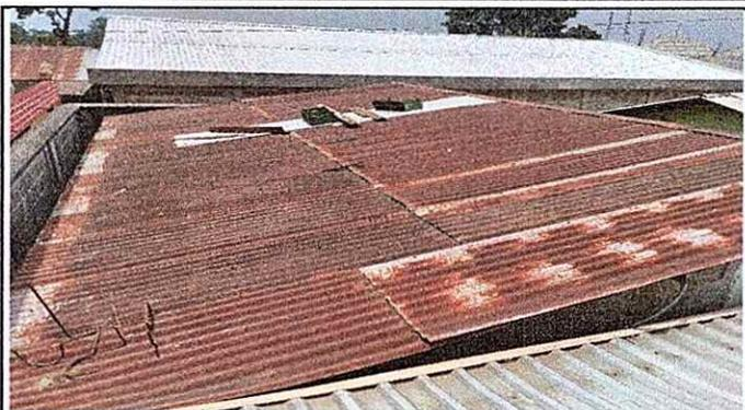
Foto 1: Vista superior del modolo 1 de trabajo, Aula con cubierta de lamina en mal estado, se solicita sustitucion.
