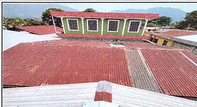
Foto 2: Vista superior del modolo 1 de trabajo. Aula con cubierta de lamina en mal estado, que se necesita sustucion.
