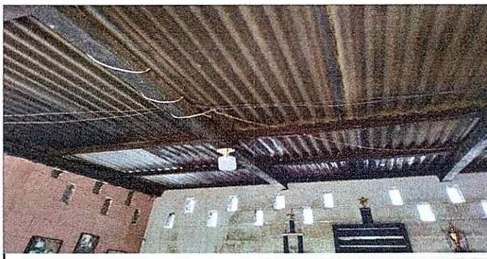
Foto 6: Modulo 3. Direccion y Bodega. Se solicita Cambio de cubierta de Lamina y Estructura.
